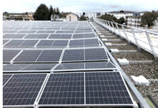
本集團在瑞士穆爾滕 (Murten) 的廠房屋頂上安裝了 900 平方米的光伏電池，每年估計可發電 123 兆瓦時。
