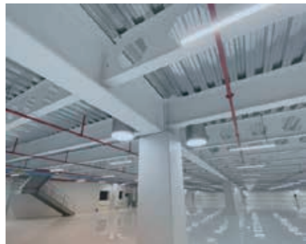
安裝在我們位於薩卡特卡斯(Zacatecas)工廠的太陽能管
