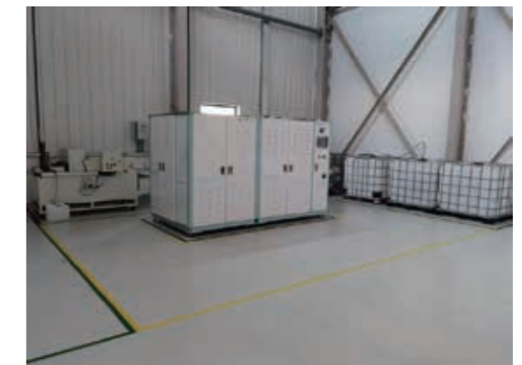
中國常州的污水處理設施
