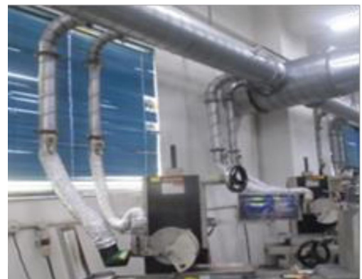
提升研磨粉塵收集系統
