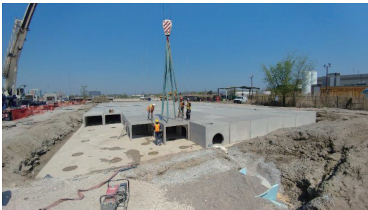
加拿大密西沙加的地下雨水收集和預防污染系統工程
